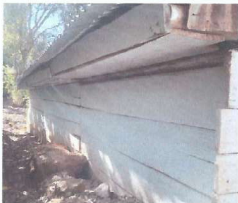
Foto1: EN ESTE ESPACIO DONDE SE ENCUENTRA INSTALADA EL AULA DE MADERA, SE CONTRUIRÍA EL MODULO TIPO PORTICO.
